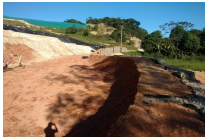
Durante a obra
