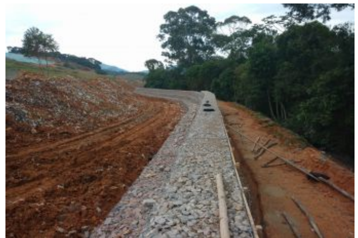
Durante a obra
