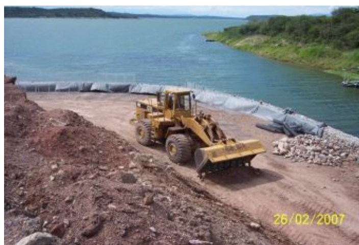
Durante a obra
