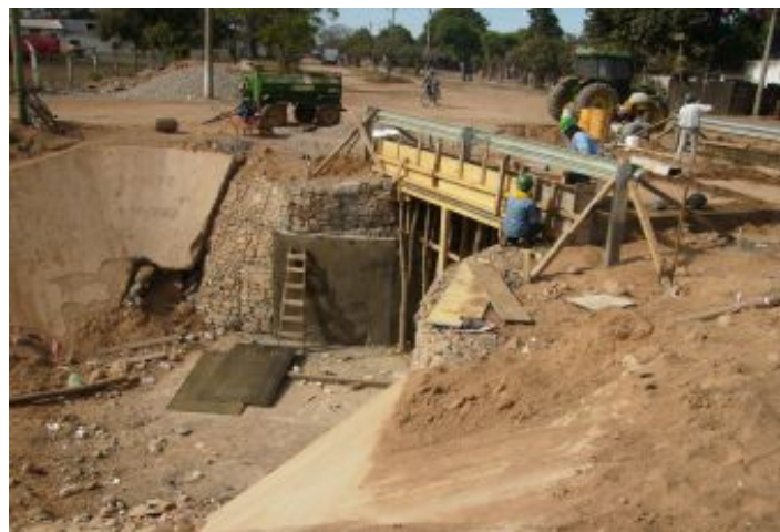
Durante a obra
