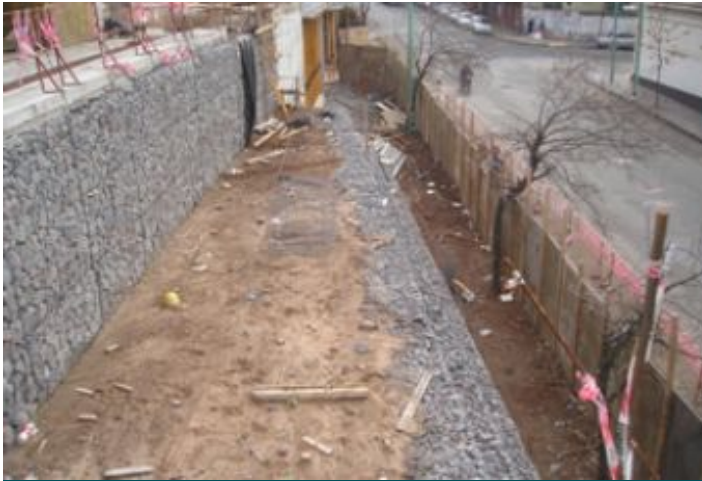
Durante a obra
