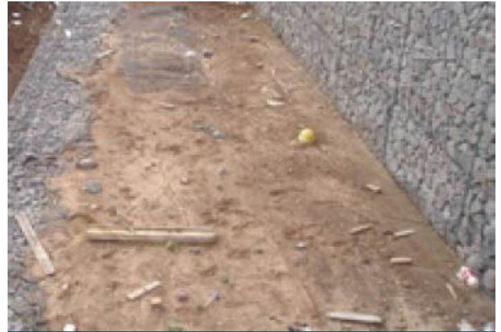
Durante a obra
