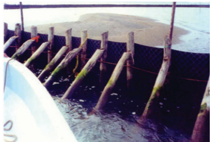
Durante la obra
