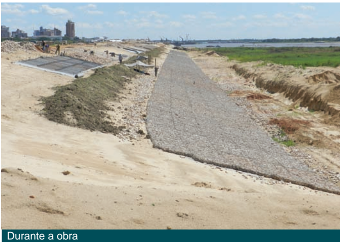
Durante a obra
