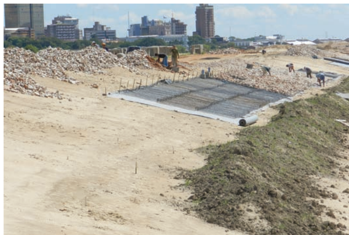
Durante a obra
