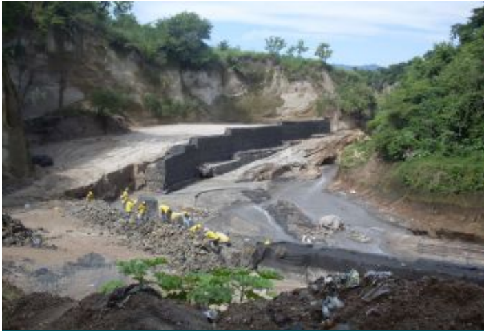
Durante a obra
