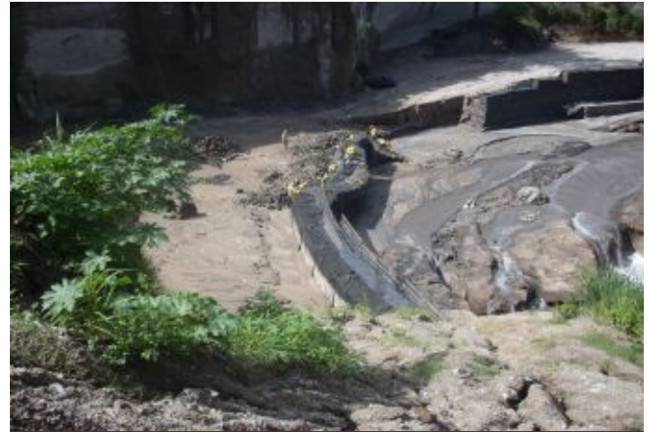
Durante a obra
