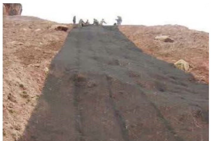
Durante a obra
