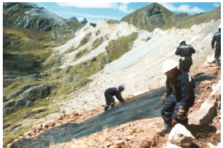
Durante a obra
