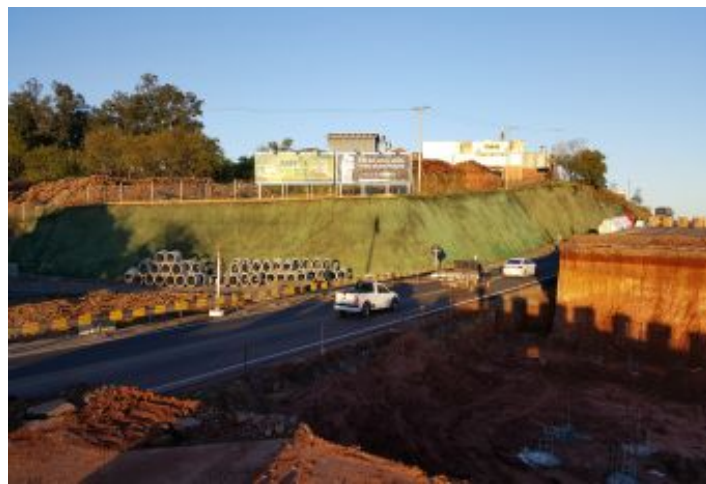
Durante a obra
