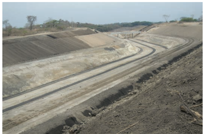
Durante a Obra
