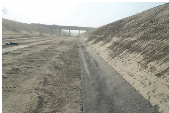
Durante a obra
