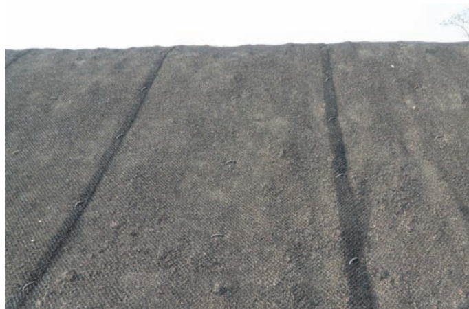
Durante a Obra
