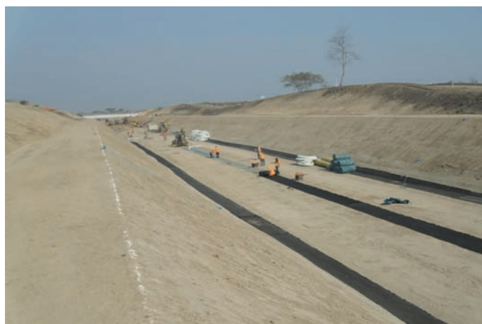
Durante a Obra
