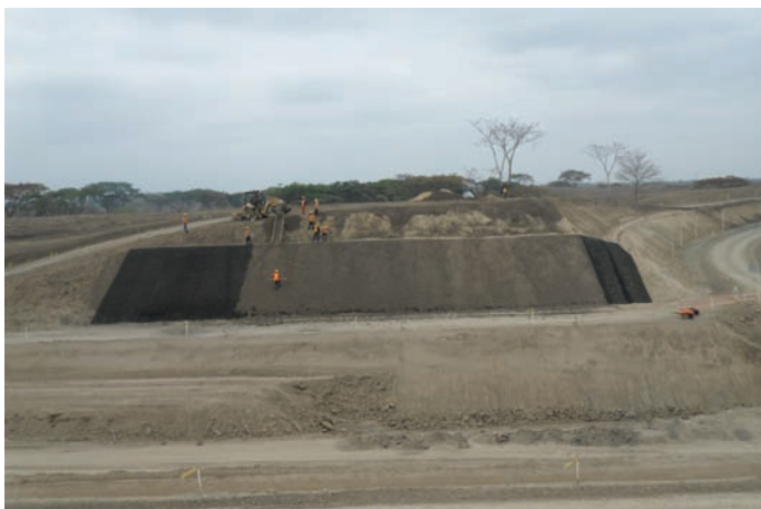
Durante a Obra
