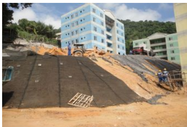
Durante a obra
