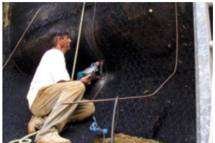
Durante a obra
