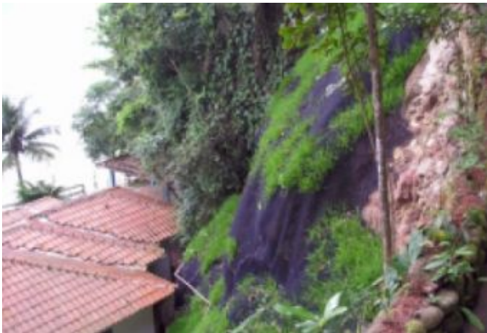
Durante a obra
