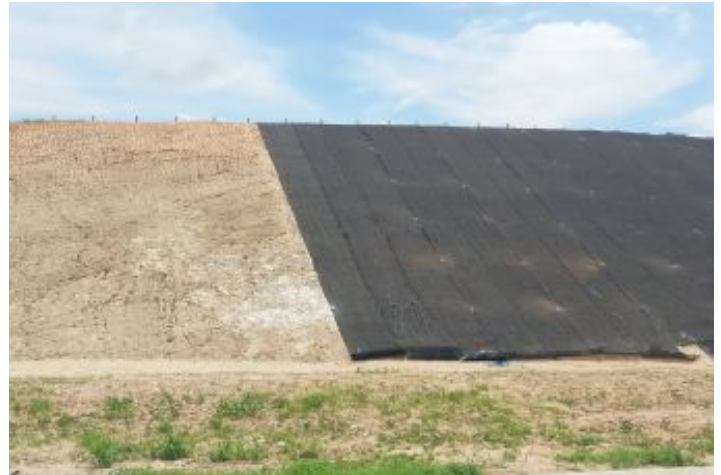
Durante a obra
