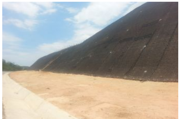
Durante a obra
