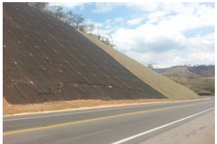
Durante a obra
