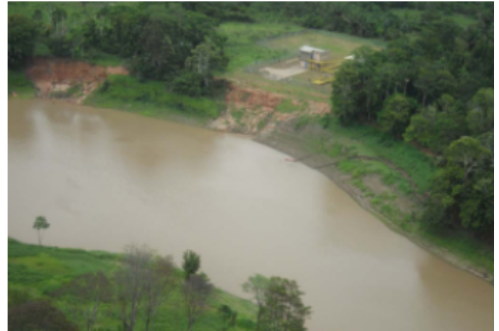
Durante a obra
