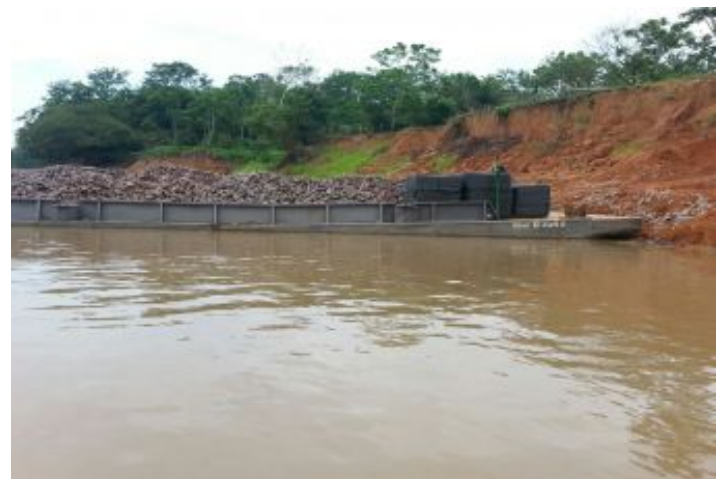
Durante a obra
