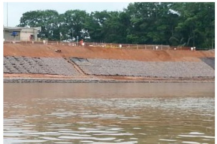
Durante a obra
