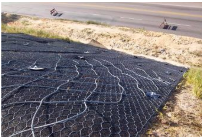
Durante a obra
