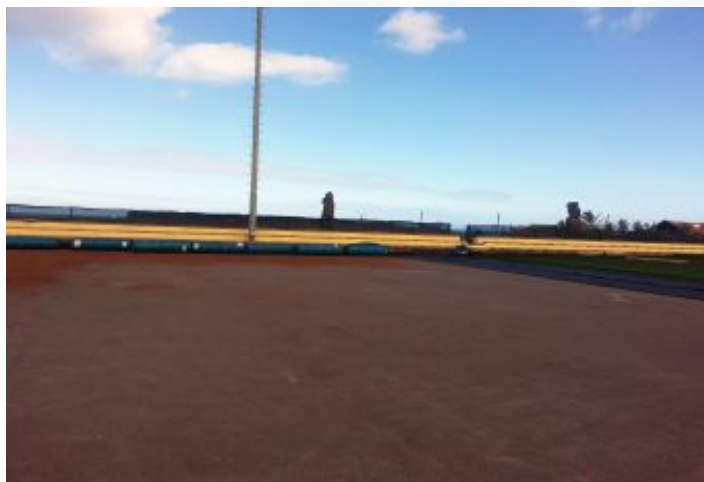
Durante a obra
