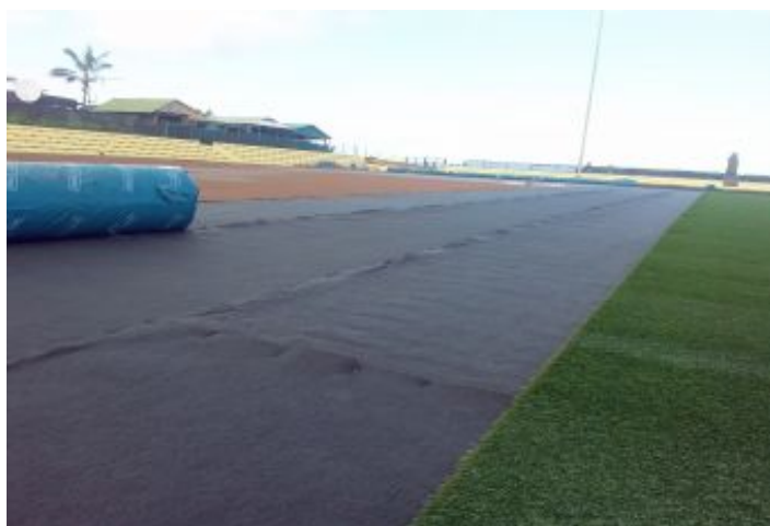
Durante a obra
