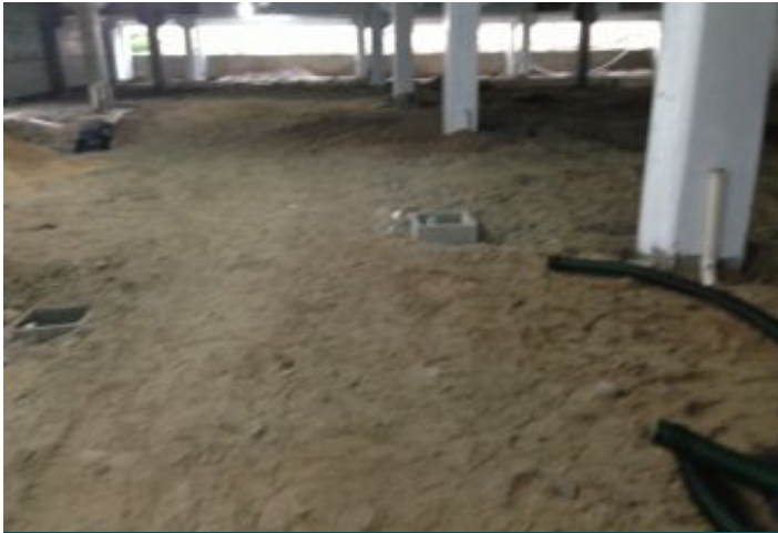
Durante a obra
