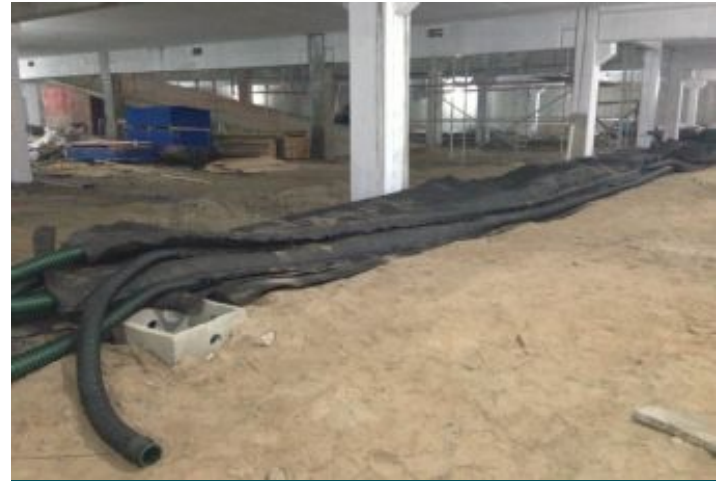
Durante a obra
