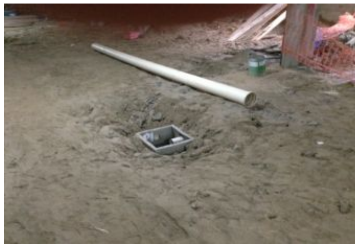
Durante a obra
