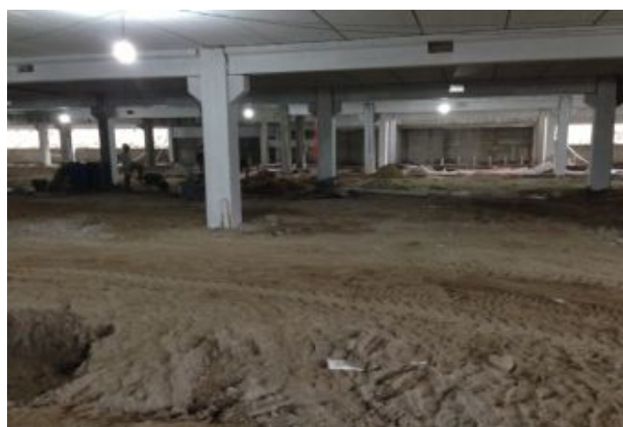
Durante a obra
