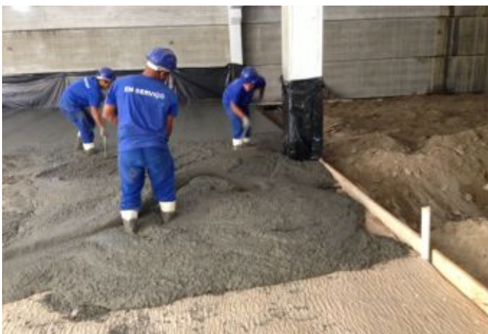
Durante a obra
