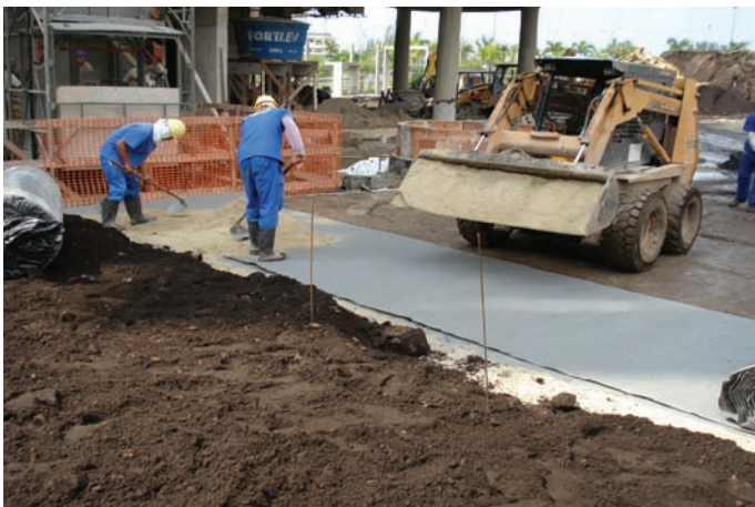
Durante a obra
