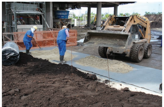
Durante a obra
