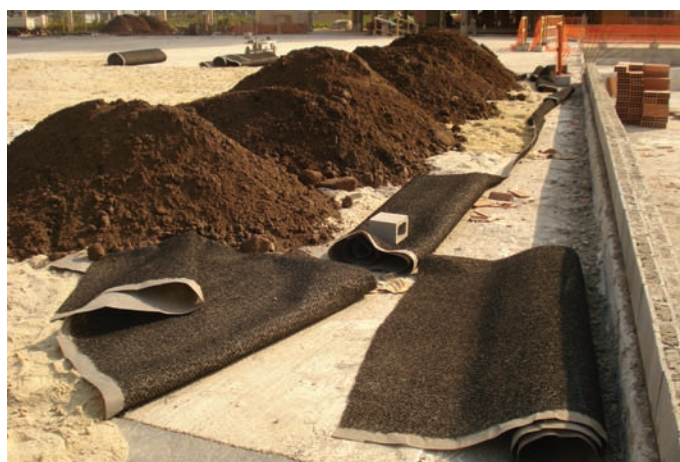
Durante a obra
