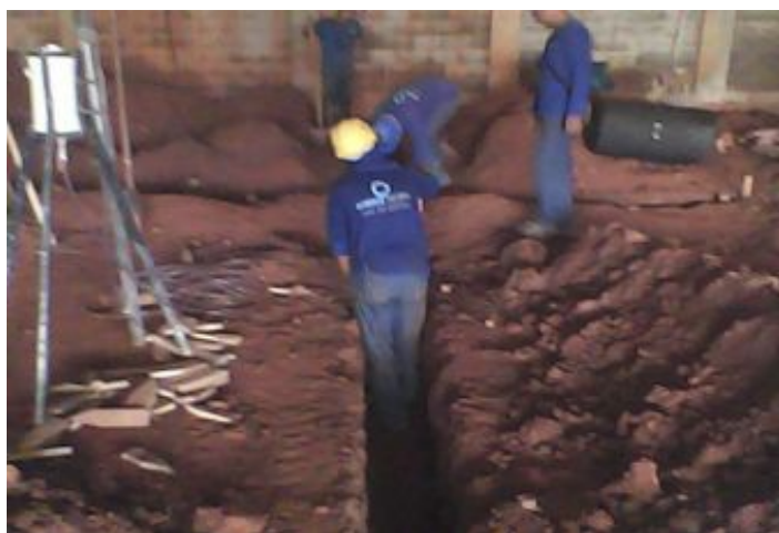
Durante a obra
