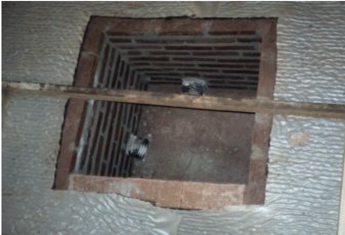
Durante a obra
