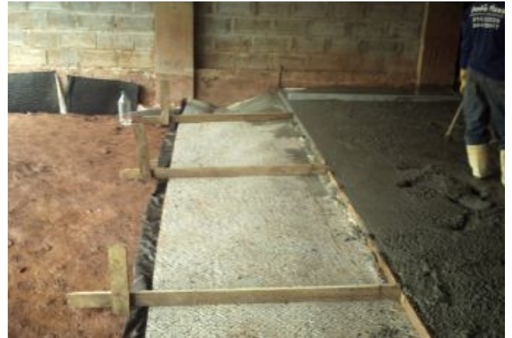
Durante a obra
