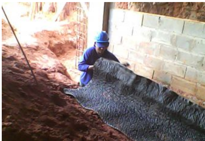
Durante a obra
