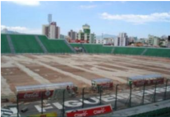
Durante a obra
