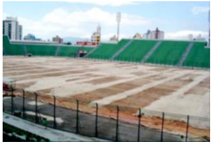
Durante a obra
