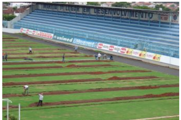
Durante a obra
