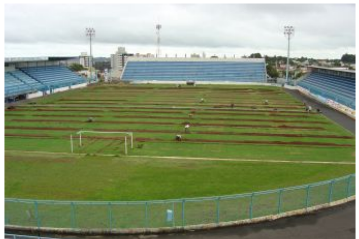
Durante a obra
