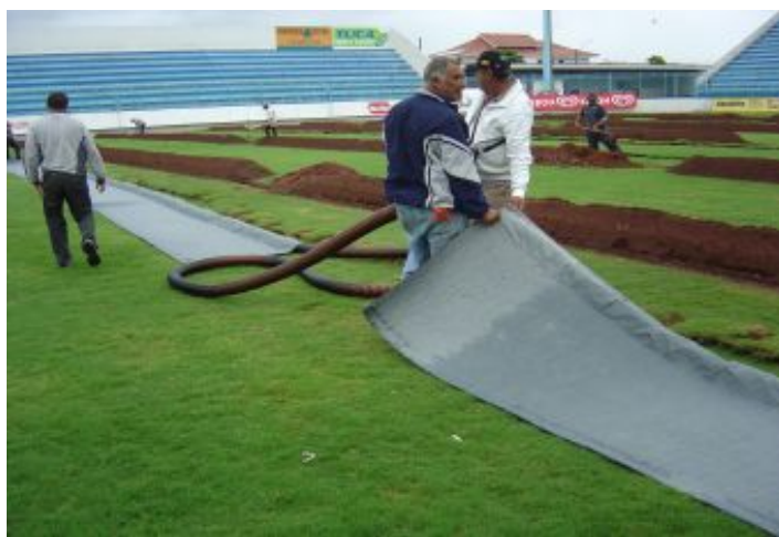
Durante a obra
