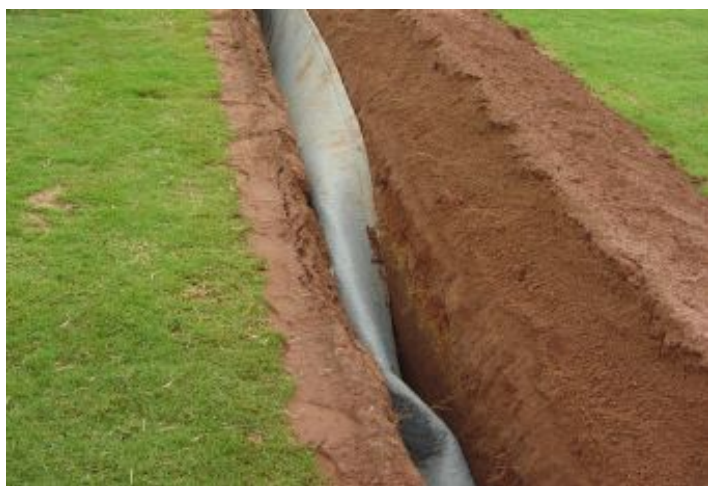
Durante a obra
