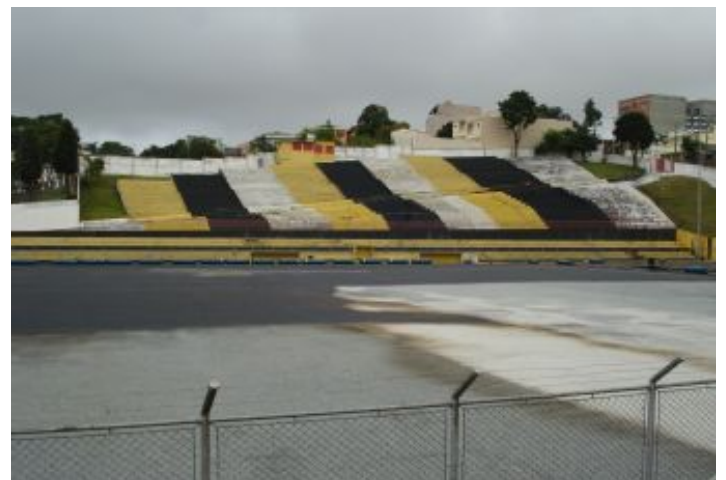
Durante a obra
