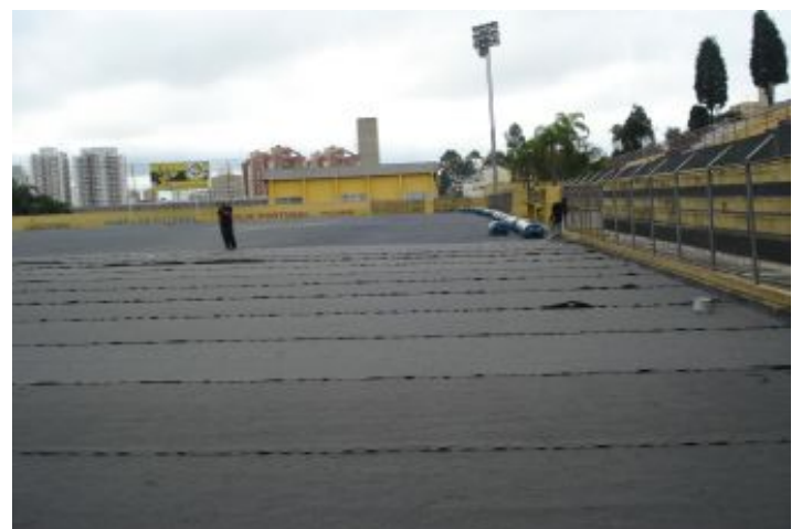
Durante a obra
