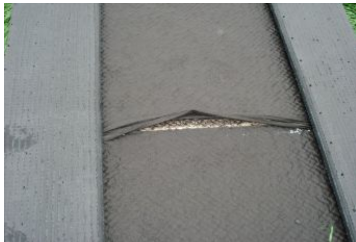
Durante a obra
