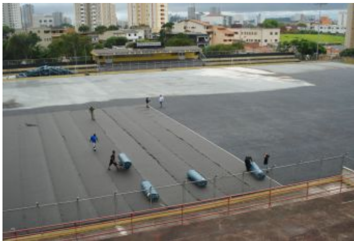
Durante a obra
