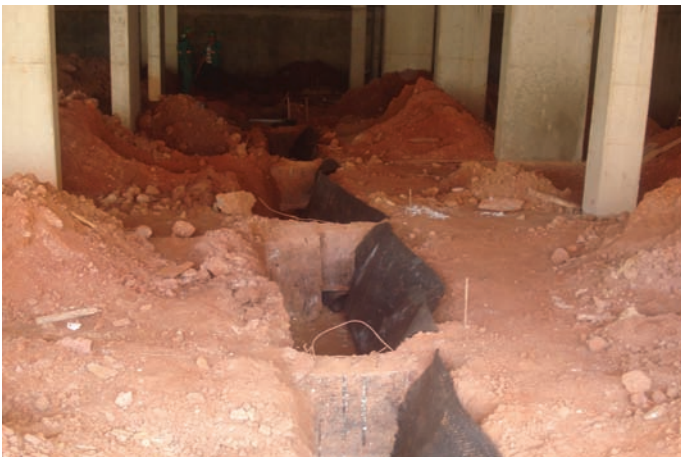
Durante a obra
