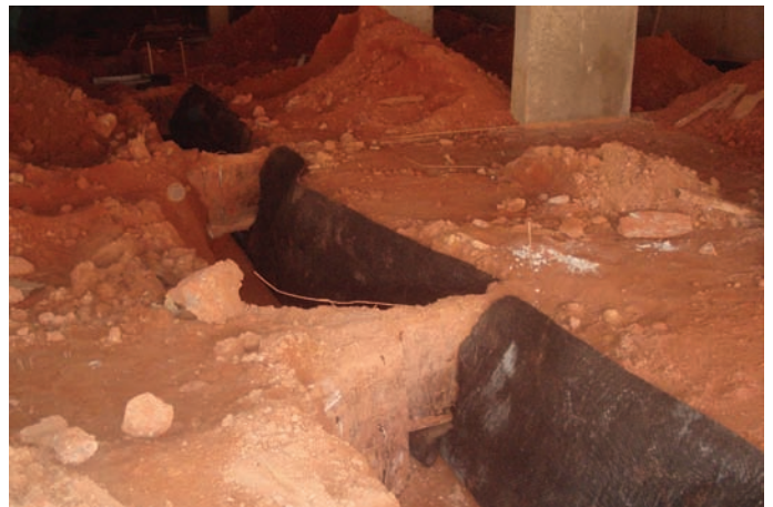
Durante a obra
