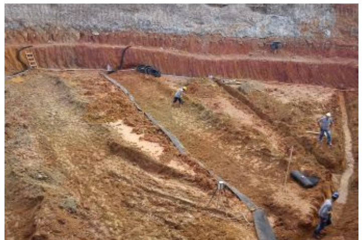
Durante a obra
