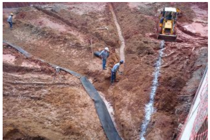
Durante a obra
