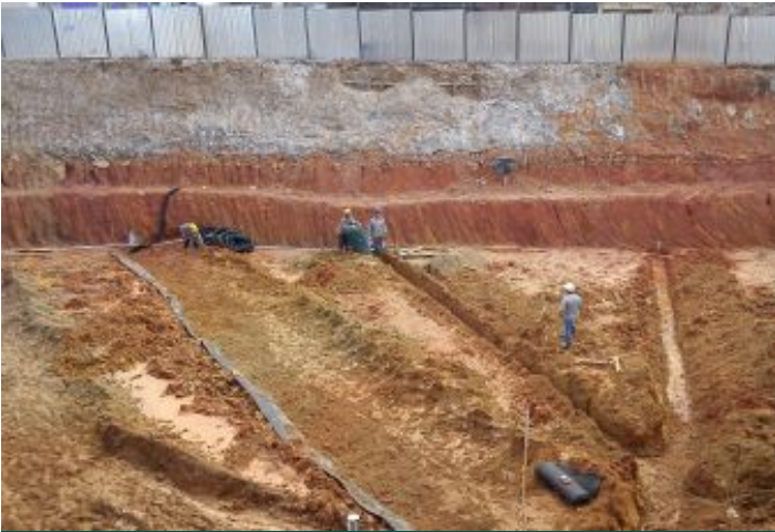
Durante a obra
