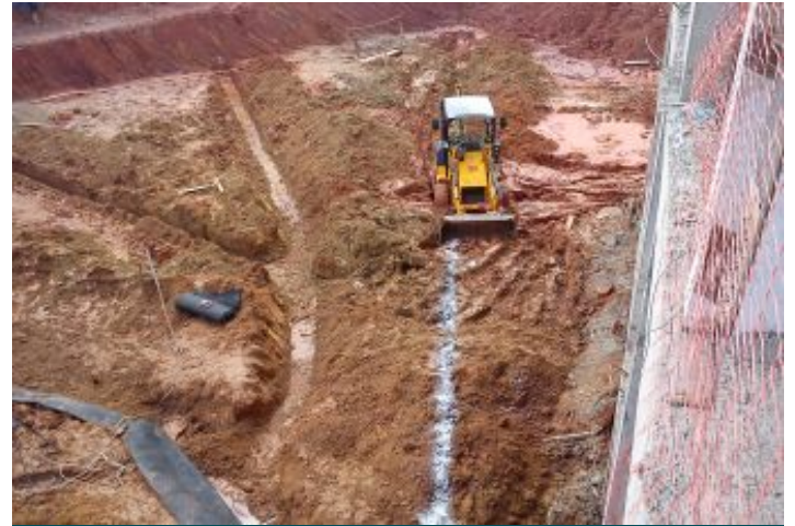
Durante a obra
