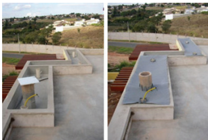
Durante a obra
