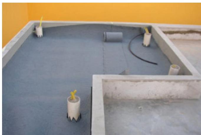
Durante a obra
