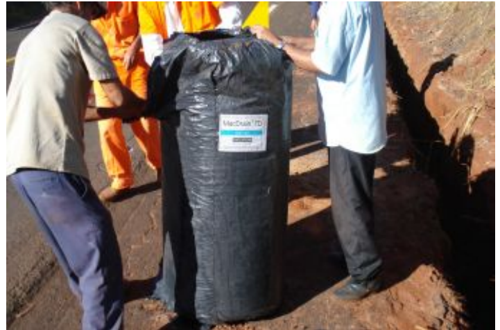
Durante a obra
