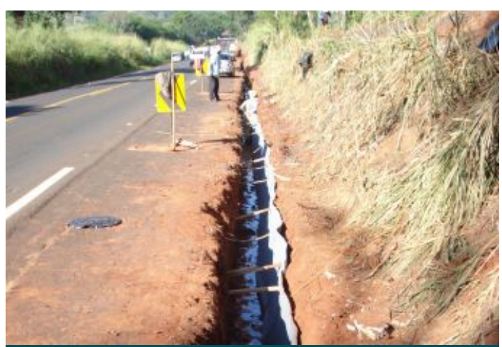
Durante a obra
