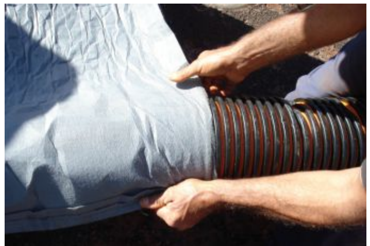
Durante a obra
