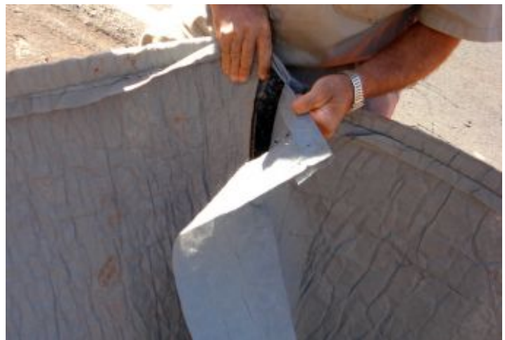
Durante a obra
