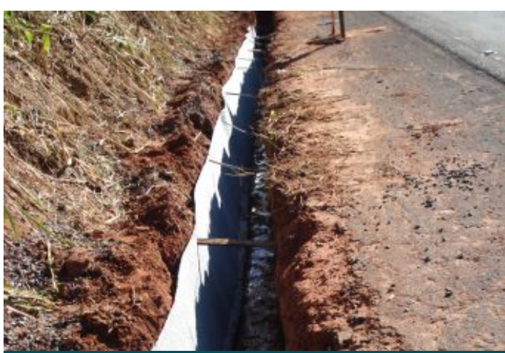
Durante a obra
