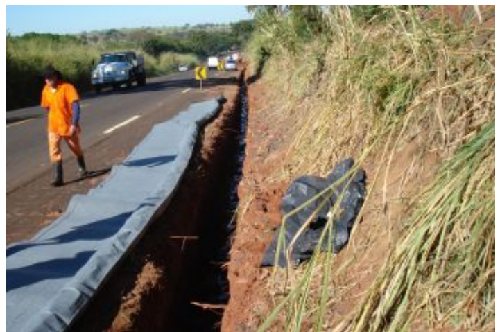
Durante a obra
