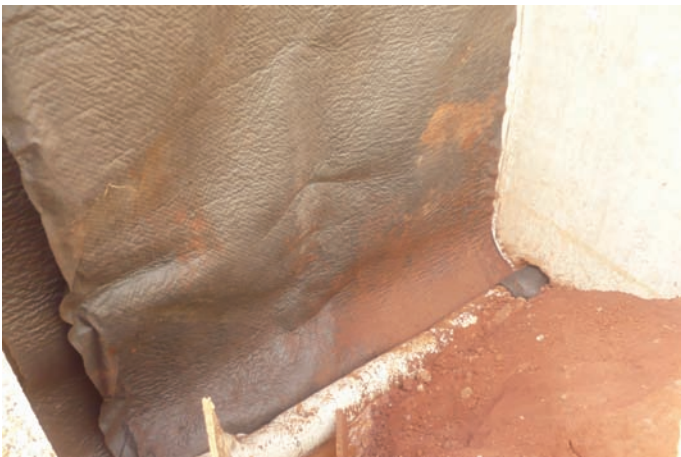
Durante a obra
