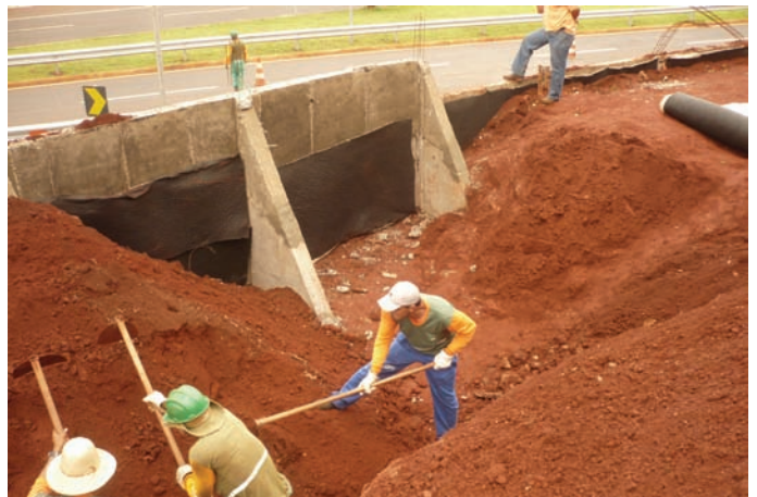
Durante a obra
