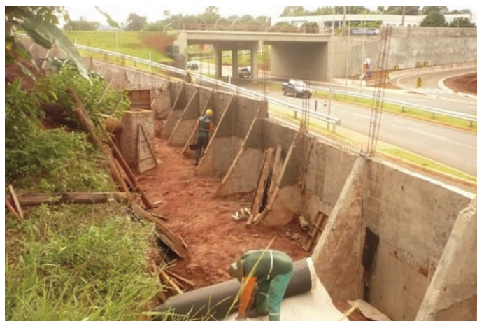
Durante a obra
