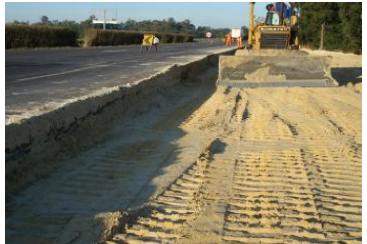
Durante a obra
