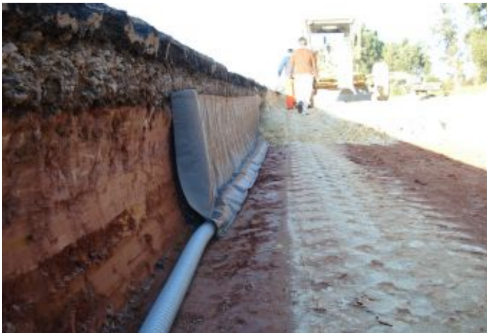
Durante a obra
