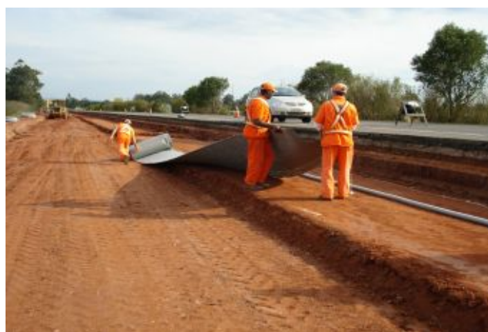
Durante a obra
