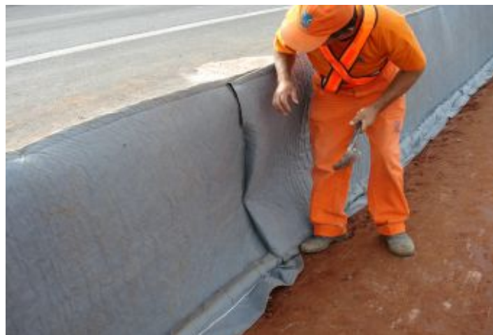
Durante a obra
