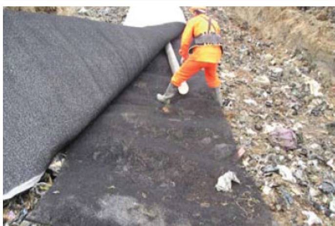
Durante a obra
