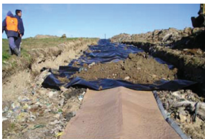
Durante a obra
