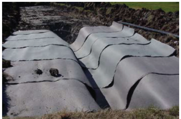
Durante a obra
