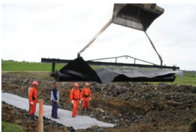
Durante a obra
