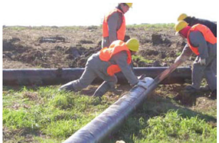
Durante a obra
