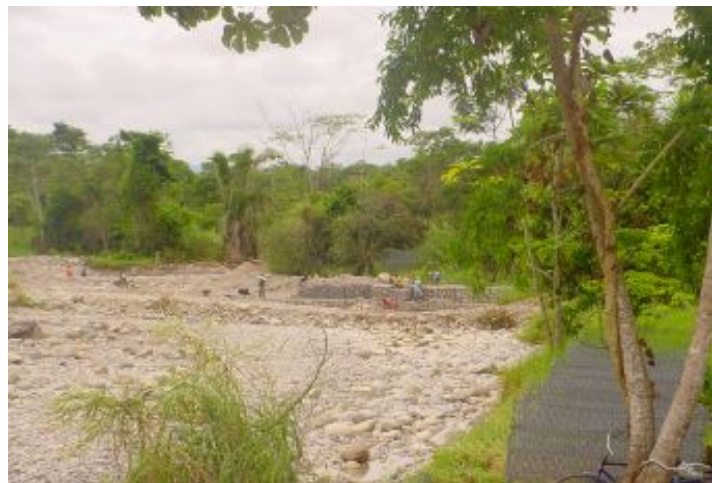
Durante a obra
