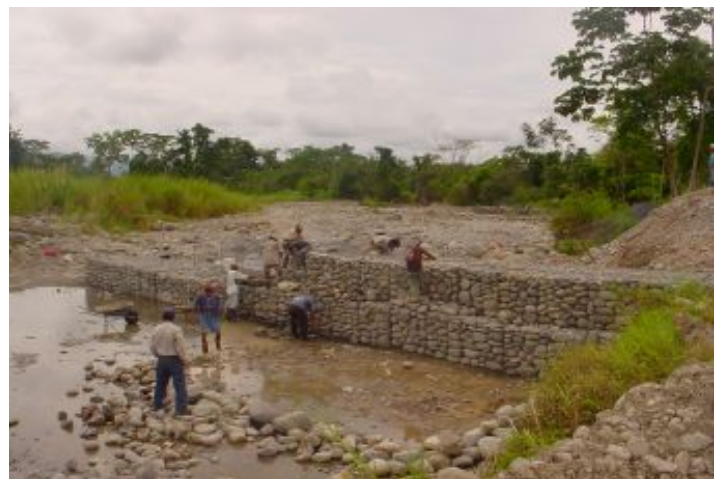
Durante a obra
