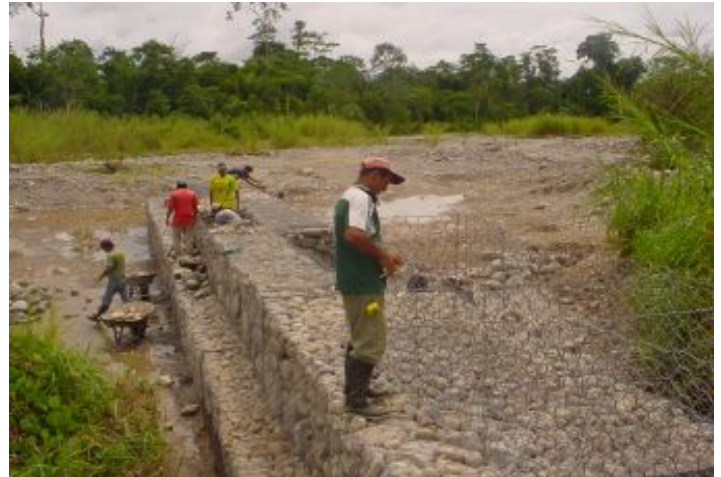
Durante a obra
