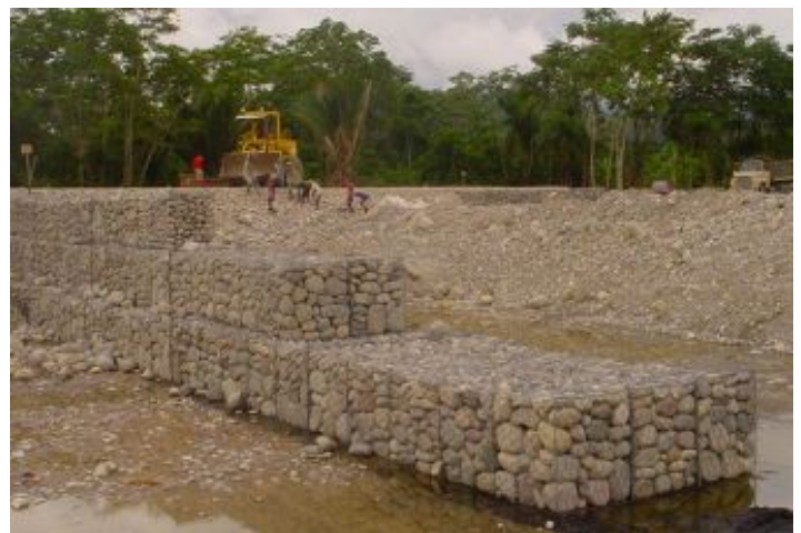
Durante a obra
