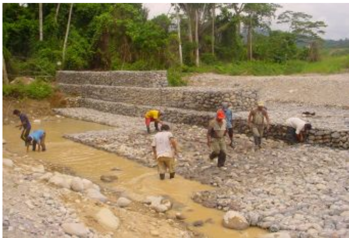
Durante a obra
