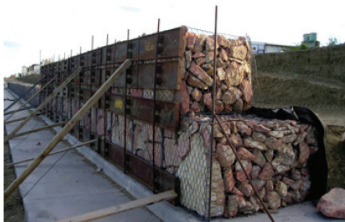
Durante a obra
