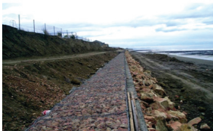
Durante a Obra
