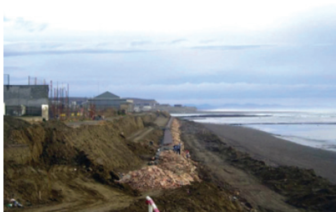
Durante a obra
