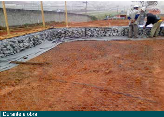
Durante a obra
