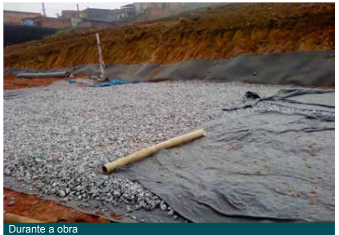
Durante a obra
