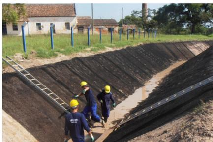
Foto 2 - Revestimento de canal de drenagem de águas pluviais com MacMat® 10.1
