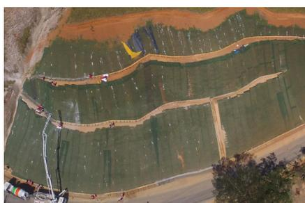
Foto 4 - Revestimento da face de um solo grampeado com MacMat® HS ou MacMat® R1
