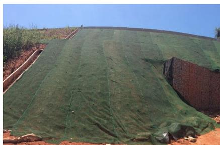
Foto 1 - Revestimento de talude acima de um muro de contenção em gabiões com MacMat® R3
