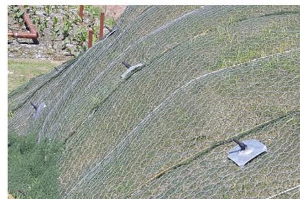
Foto 3 - Revestimento da face de um solo grampeado com MacMat® HS
