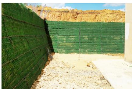
Foto 5 - Revestimento da face de contenções em solo reforçado com MacMat® 10.1
