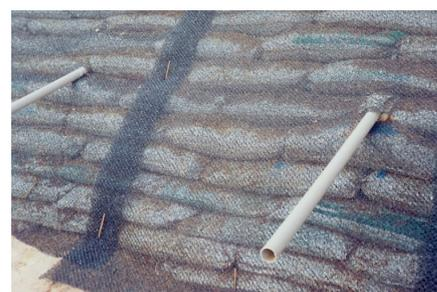
Foto 6 - Revestimento da face de uma recuperação de erosões em solo ensacado com MacMat® 10.1
